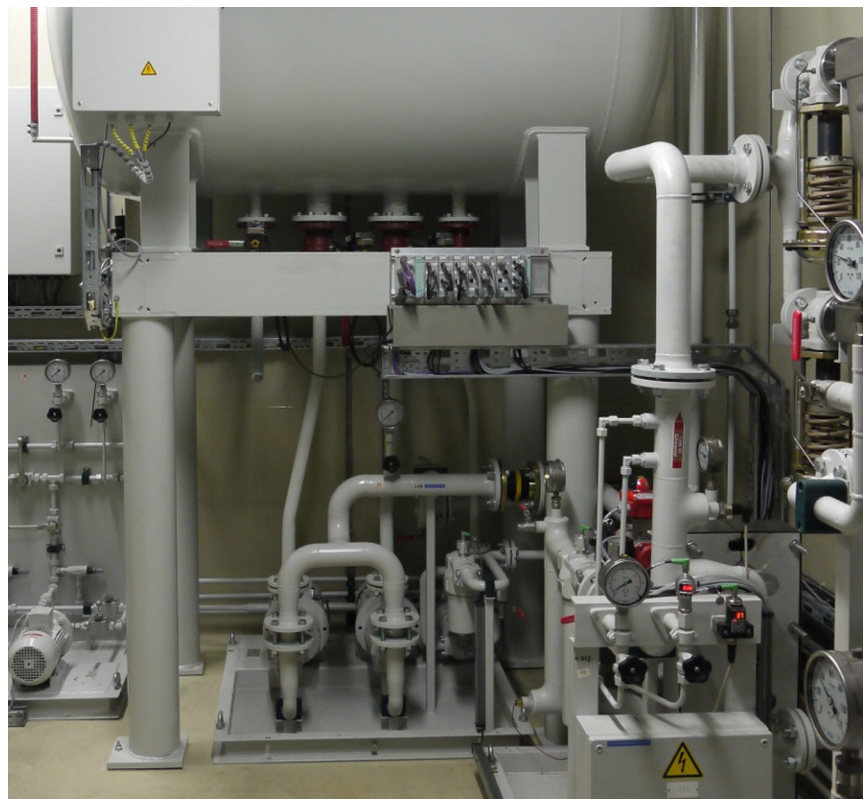
Vakuumölstation, installiert unterhalb des Vakuumöltanks, und Vakuumölverteilung mit Filterung, Flussüberwachung und Druckregelung
